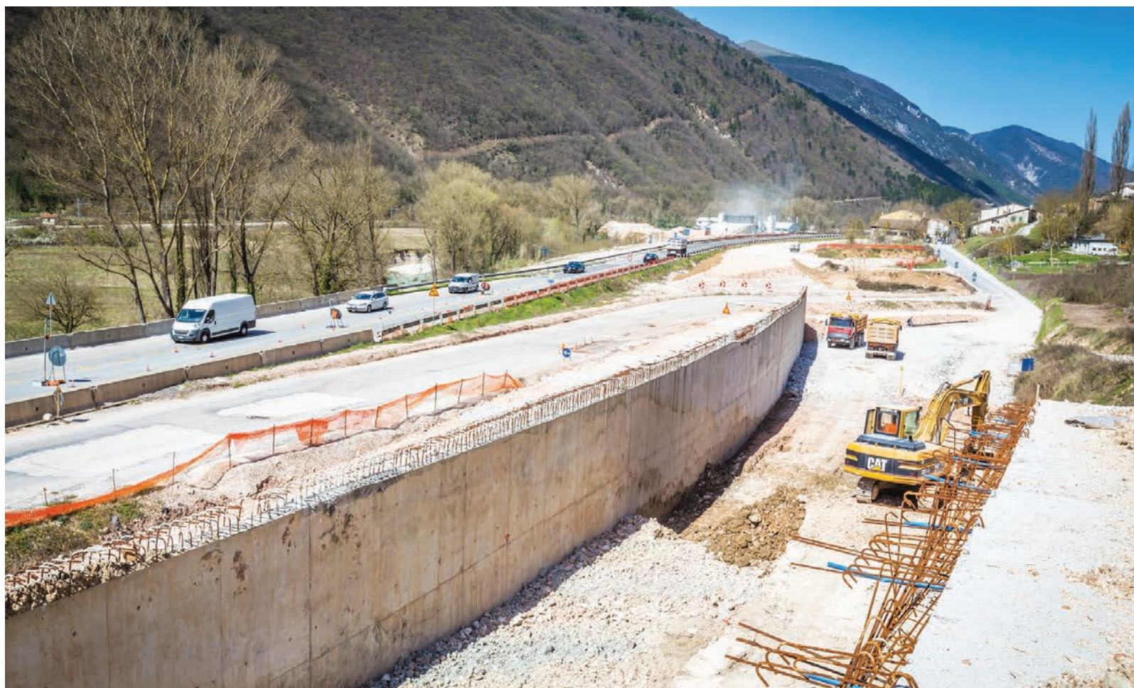
I lavori per il raddoppio della Ss 76 (foto di repertorio)
